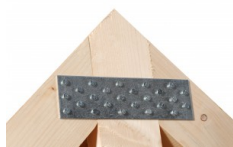
Assemblage de 3 éléments par plaques perforées NP
