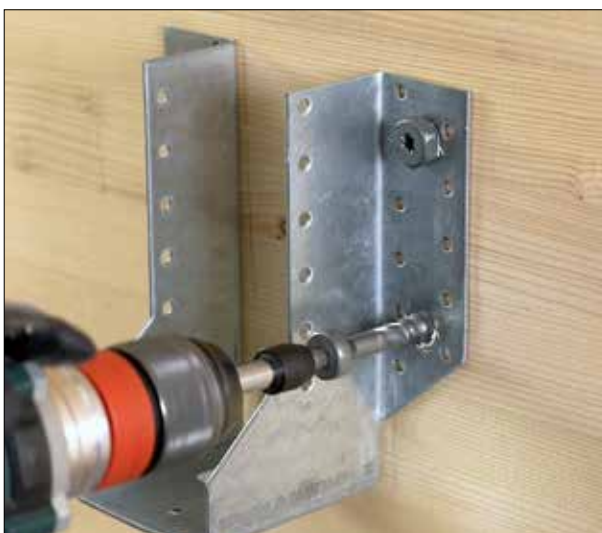
Ophangbeugel SAE geïnstalleerd met SSH
