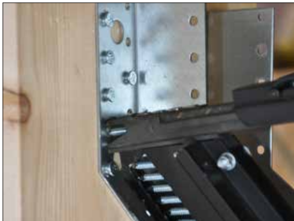
Ophangbeugel SAE geïnstalleerd met CNAPC34
