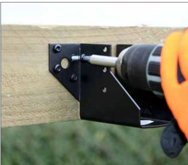
Zwarte SAE-PB -ophangbeugel geïnstalleerd met CSA-PB -schroeven
