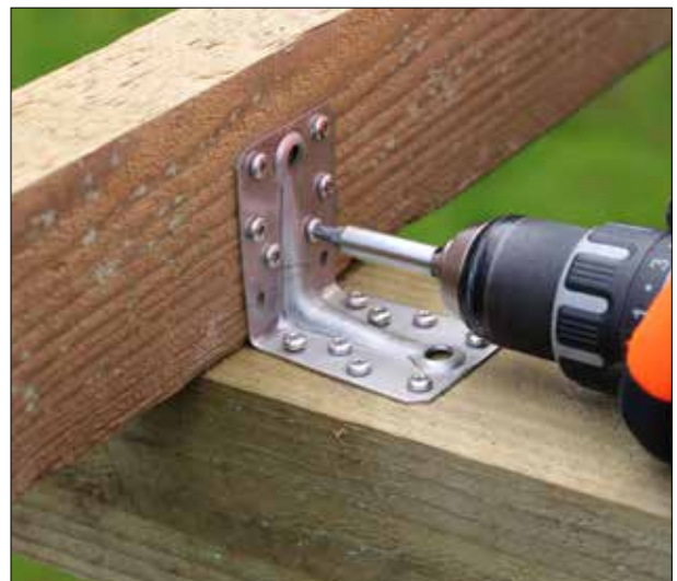
A4 roestvrijstaal ABR7015S geïnstalleerd met CSA-S -schroeven van A4 roestvrij staal
