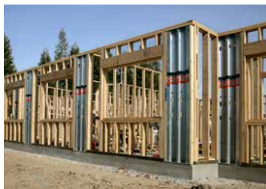
Voorbeeld van houtskeletbouw met Steel Strong-Wall™
