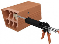
4. Vullen vanaf bodemgat naar buiten door bij het pompen telkens één maatstreep op de spuitmond achteruit te gaan.
